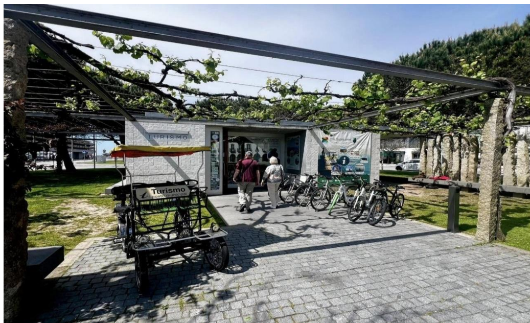
Figura 45 - Exterior do Posto Municipal de Turismo de Viana do Castelo
