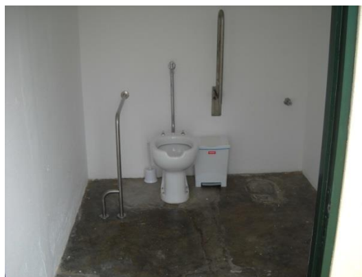
Fig. 18 - Instalação sanitária da Praia da Lagoa
