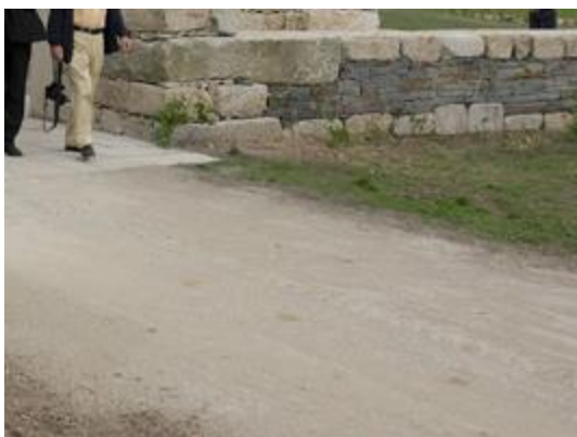
Fig. 33 - Percurso sem pavimento
