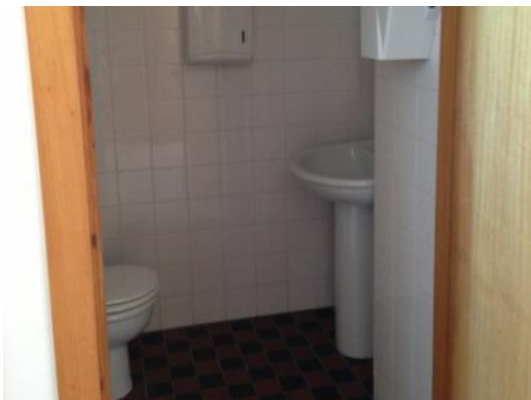
Fig. 89 – Instalação sanitária na Marina
