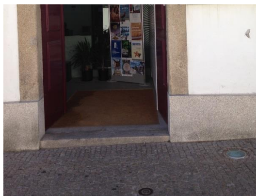
Fig. 110 - Degrau no acesso ao Museu
