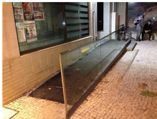
Fig. 56 - Rampa no Restaurante Albatroz
