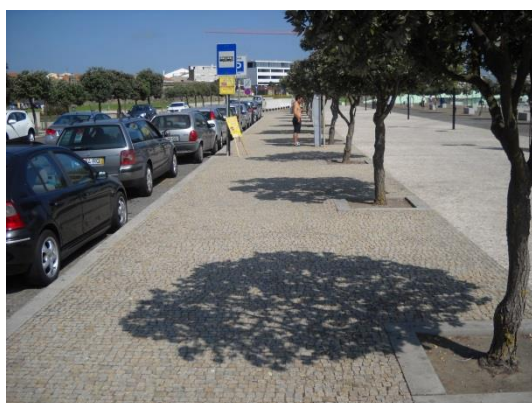
Fig. 19 - Estacionamento sem reserva para PMC
