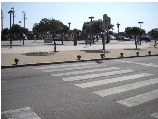
Fig. 21 - Passadeira sem rebaixamento
