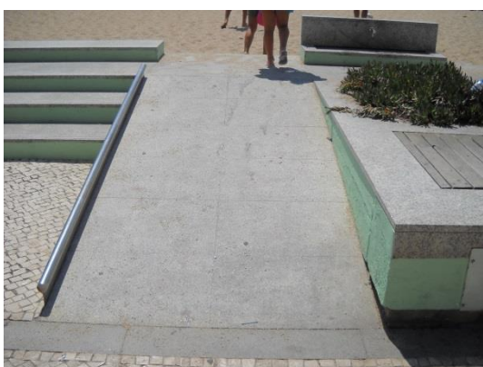
Fig. 69 - Rampa de acesso ao Ferrari
