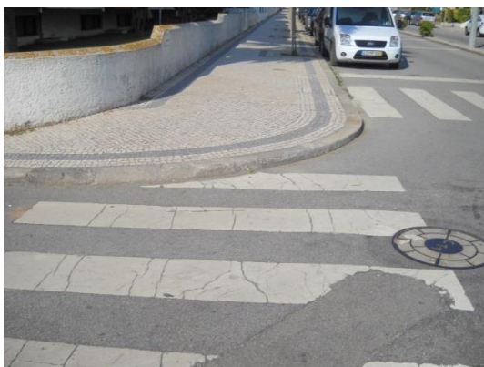
Fig. 3 - Passadeira na Av. Santos Graça
