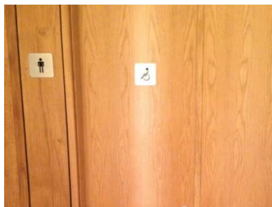
Fig. 125 - Detalhe da sinalização da porta da I.S.
