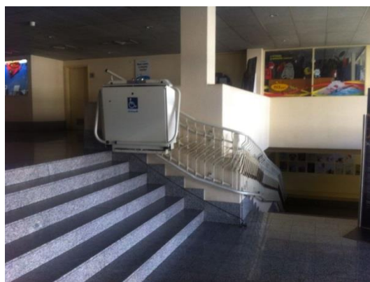
Fig. 85 - Escada de acesso à Varzim Lazer
