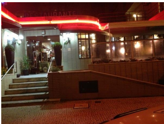
Fig. 55 - Rampa no Restaurante O Pátio
