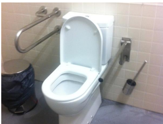
Fig. 17 - Instalação sanitária da Praia do Quião
