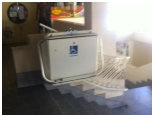
Fig. 92 - Plataforma elevatória no Varzim Lazer
