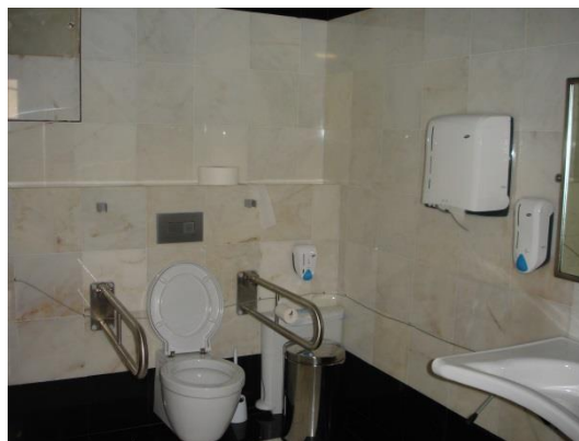
Fig. 104 - Instalações Sanitárias do Casino
