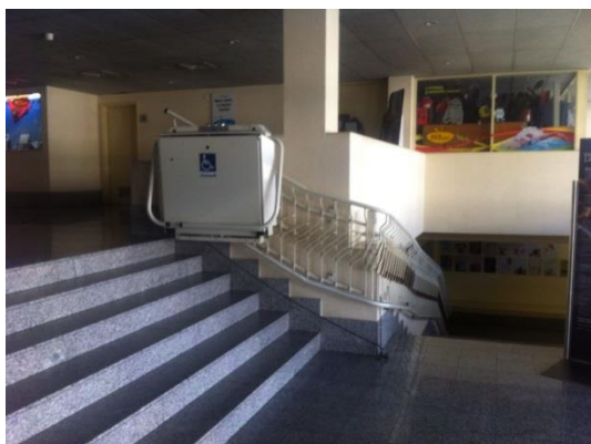
Fig. 91 - Plataforma elevatória no Varzim Lazer
