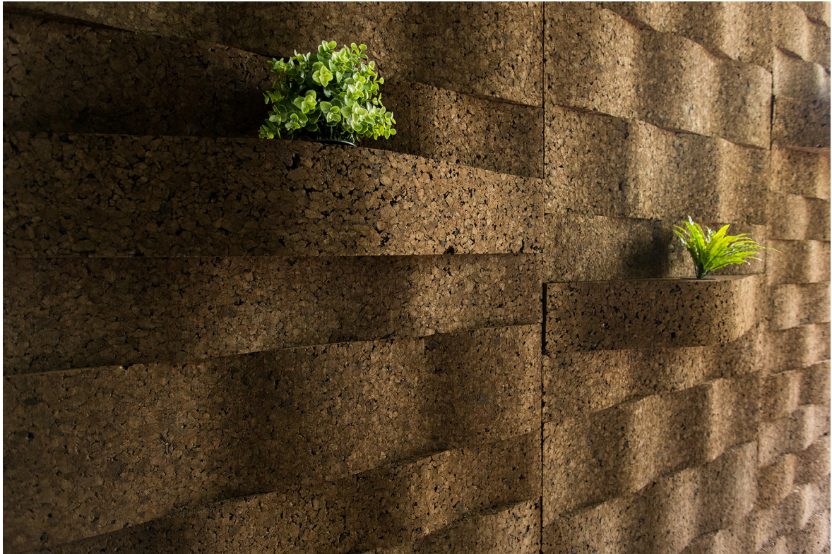
Figura 25 - Aplicação de Cortiça na parede. 98
