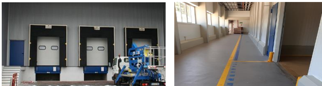
Figura 34 – Cais com portas de segurança pintadas conforme delimitação de segurança
