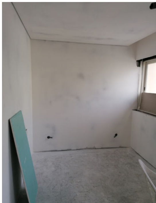
Figura 160 – Fotografia do quarto avó (antes do projeto)
