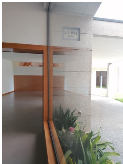
Figura 147 – Fotografia da entrada para a sala (antes do projeto)
