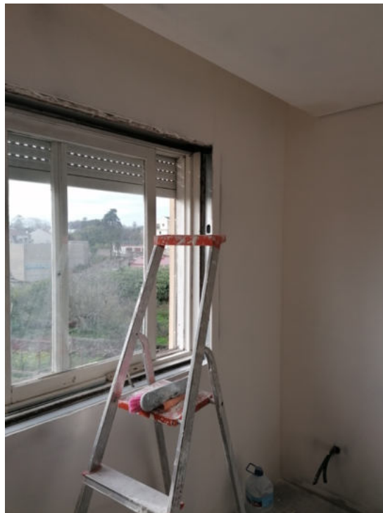
Figura 158 – Fotografia da janela (antes do projeto)
