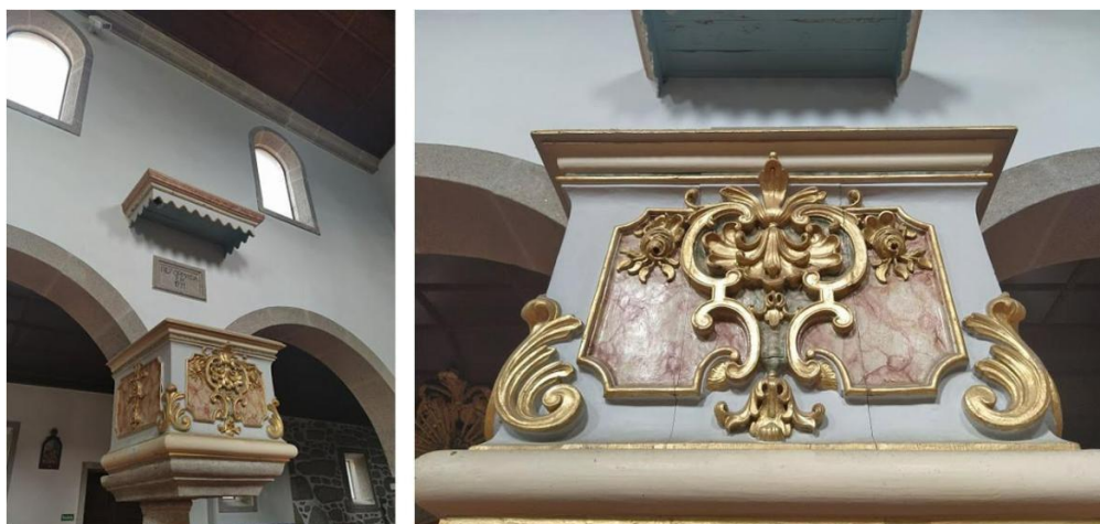
Figura 33- Da esquerda para a direita: Púlpito situado na parede lateral esquerda da nave central. Caixa apainelada com o interior marmoreado e com ornatos em talha dourada- Fonte: Anaïs ROLO
