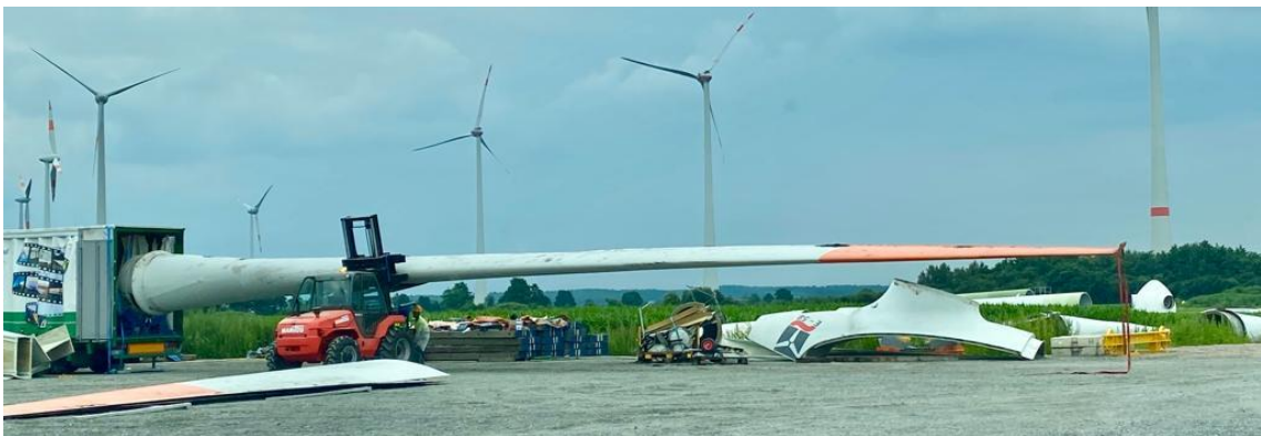
Imagem 2– Passo 2 do corte de pás
