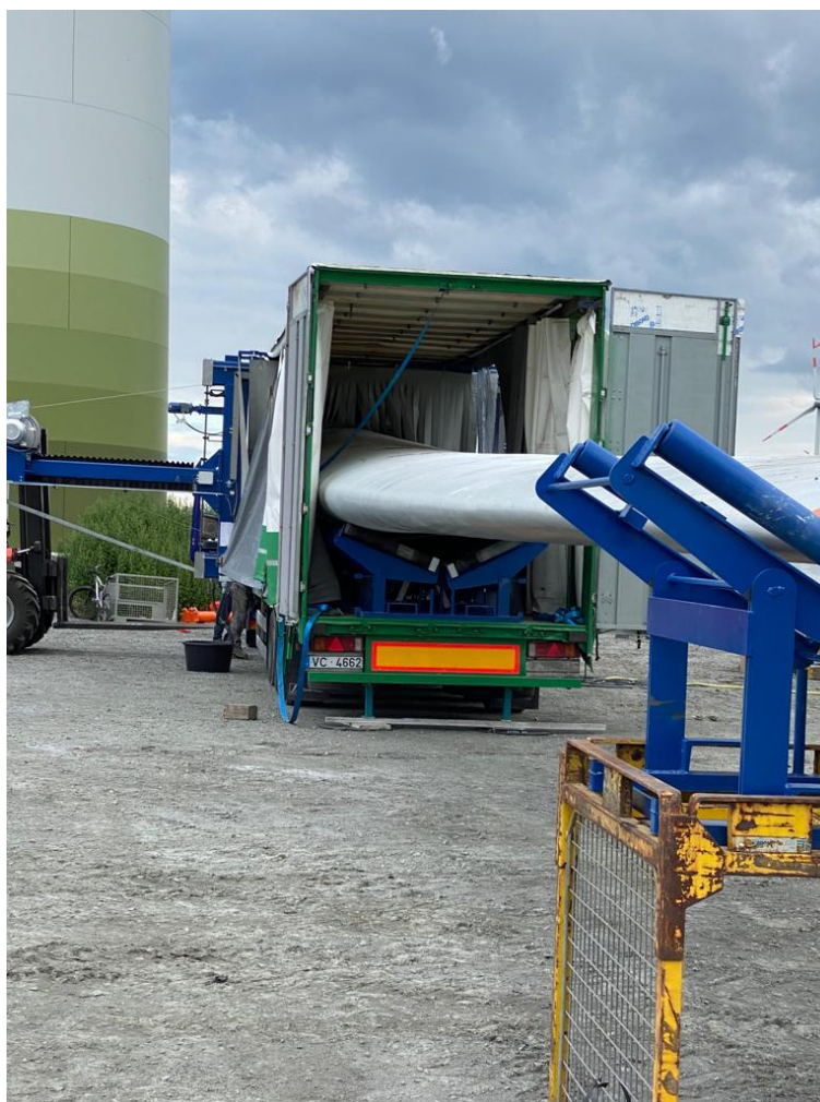
Imagem 4 – Passo 4 do corte de pás
