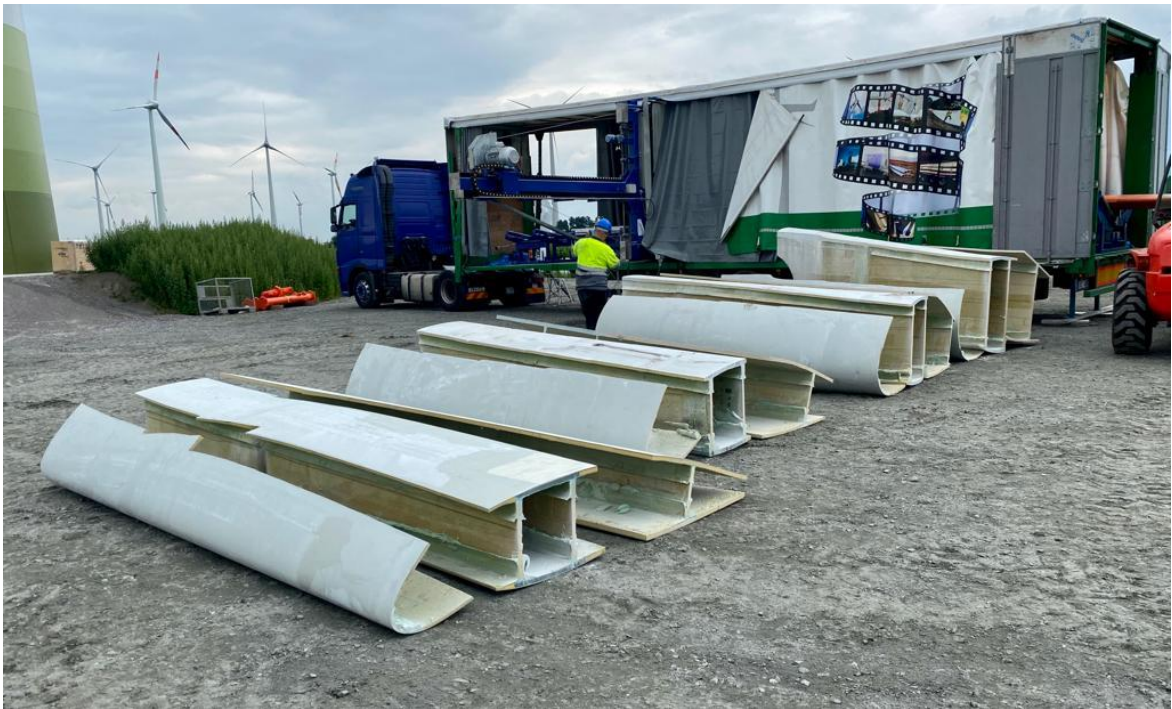
Imagem 9 – Passo 9 do corte de pás
