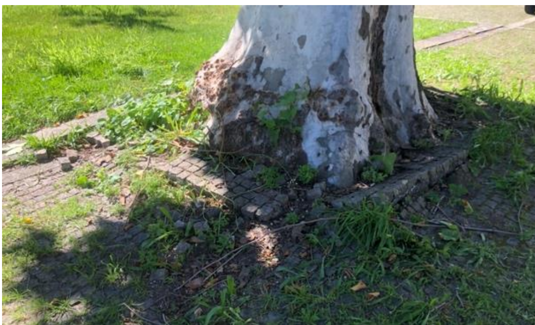
Figura 47 - Pavimento em volta do plátano no pátio interior dos Serviços Centrais e da Presidência do Instituto Politécnico de Viana do Castelo
