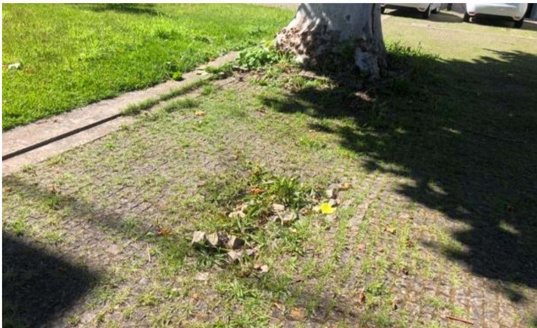
Figura 46 - Pavimento em volta do plátano no pátio interior dos Serviços Centrais e da Presidência do Instituto Politécnico de Viana do Castelo
