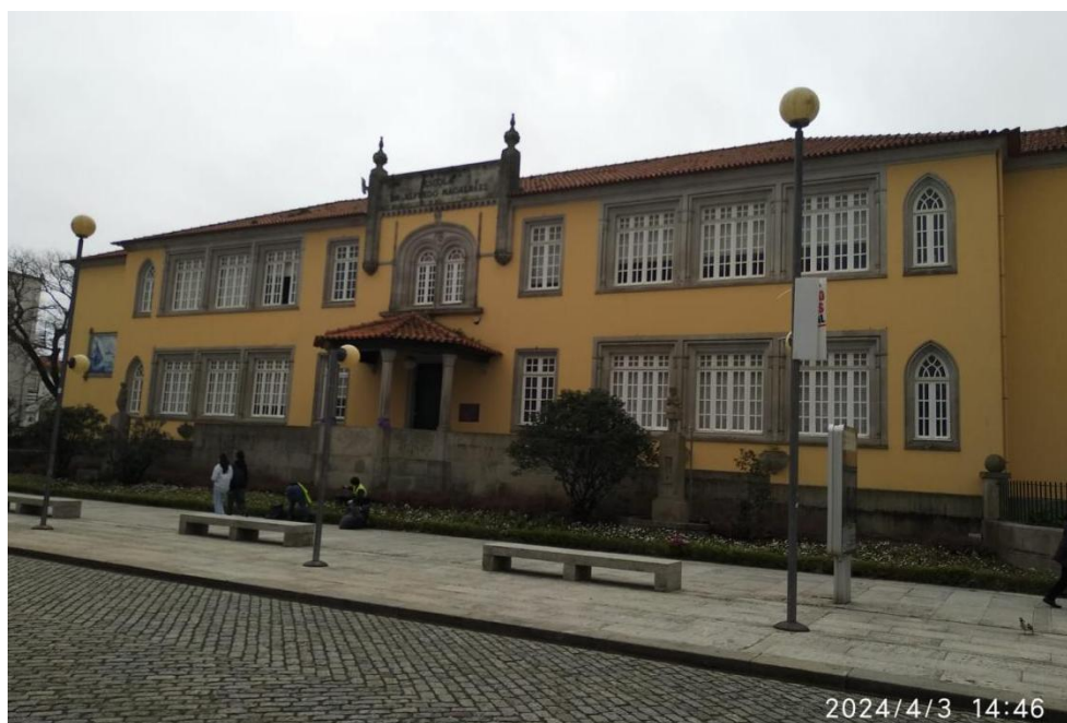
Figura 44 Escola da Avenida
