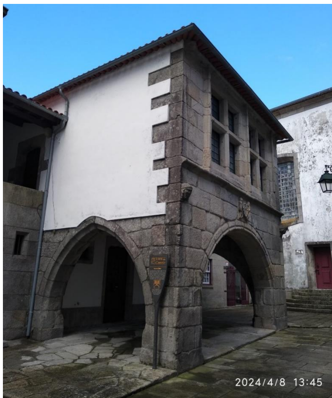
Figura 32 Casa dos Arcos
