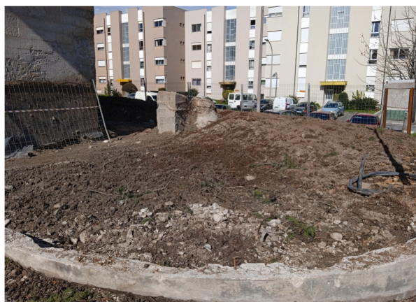
Figura 37: Demolição de muro exterior em betão armado (0,20 m)
