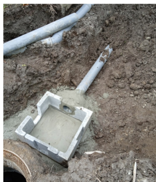
Figura 43: Instalação de caixas de visita e recolha (0.40 a 0.80 m)
