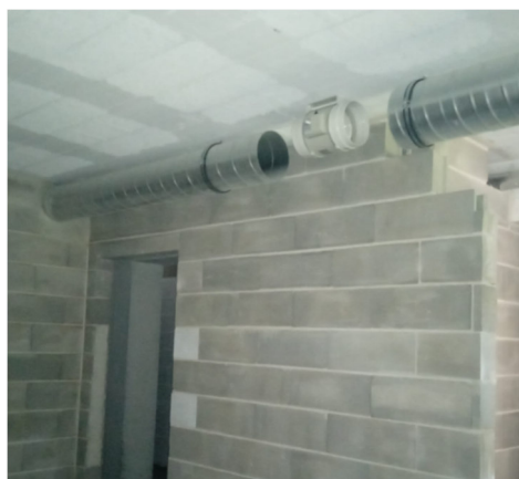
Figura 56: Instalação de ventiladores
