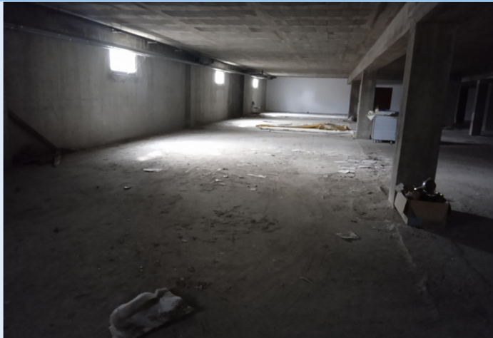
Figura 18: Interior do Edifício (1)
