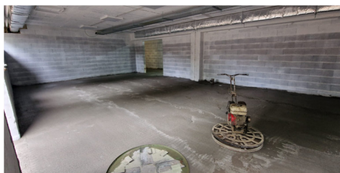
Figura 77: Execução de pavimento interior
