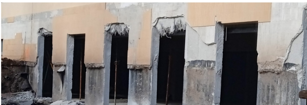
Figura 88: Fachada Sul - reboco
