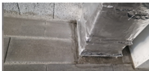
Figura 58: Montagem de registos automáticos de caudal
