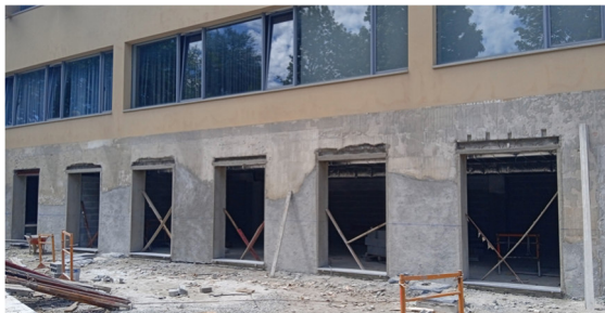
Figura 35: Fixação de perfis HEA
