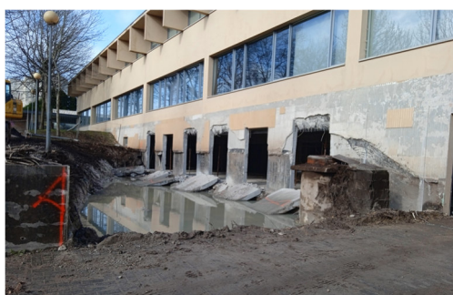
Figura 29: Abertura de vãos
