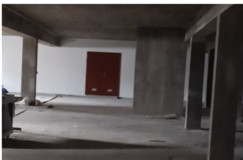
Figura 34: Desmonte de porta de madeira
