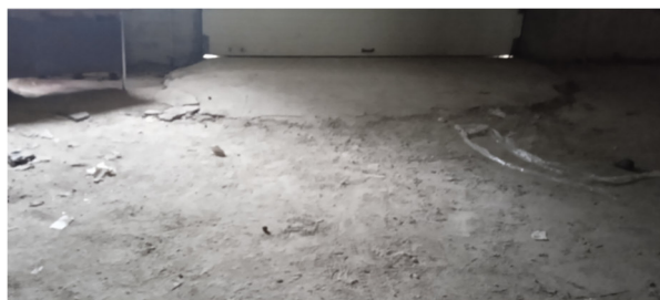
Figura 36: Remoção de enchimento em argamassa (6 cm)
