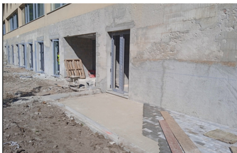
Figura 81: Reassentamento de pavê
