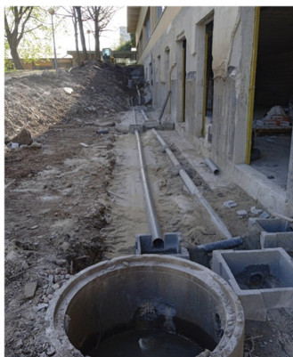
Figura 42: Assentamento de tubagens em PVC
