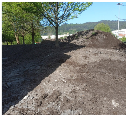
Figura 83: Distribuição de terra vegetal
