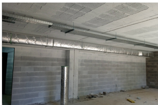
Figura 57: Aplicação de condutas
