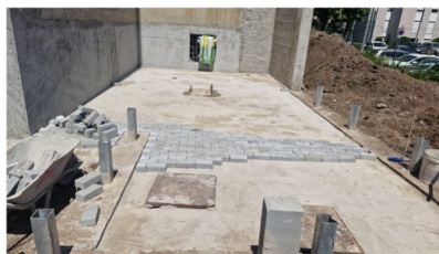
Figura 80: Assentamento pavimento UTA
