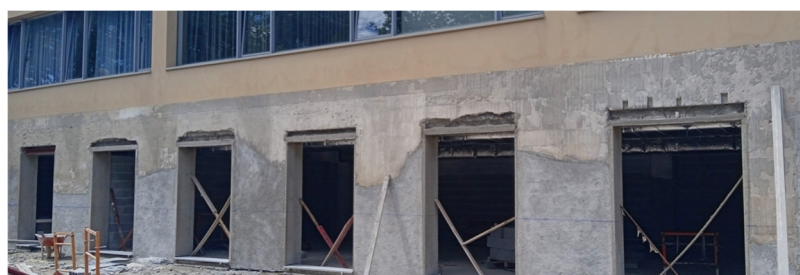
Figura 86: Fixação e isolamento Perfis HEA (1)
