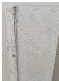
Figura 33: Remoção de peitoris
