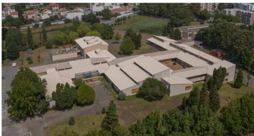
Figura 6: Edifício da ESE
