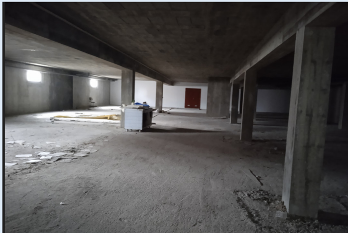
Figura 19: Interior do edifício (2)
