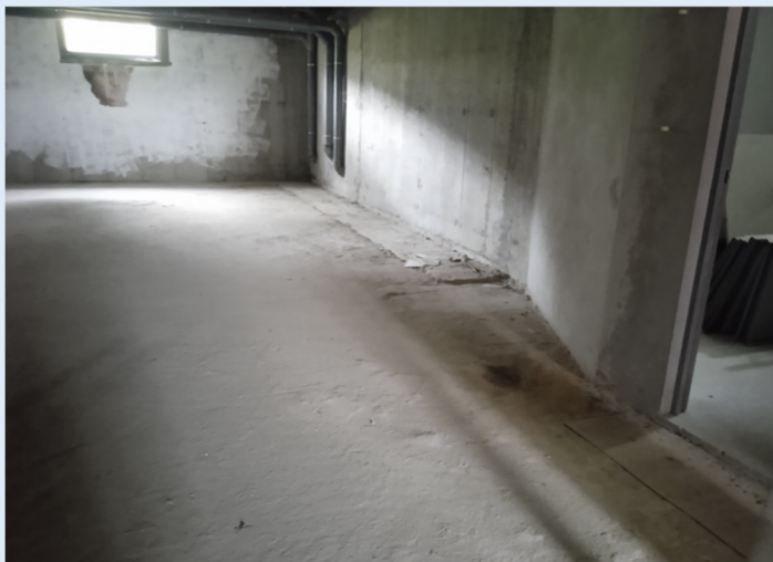
Figura 20: Interior do edifício (3)
