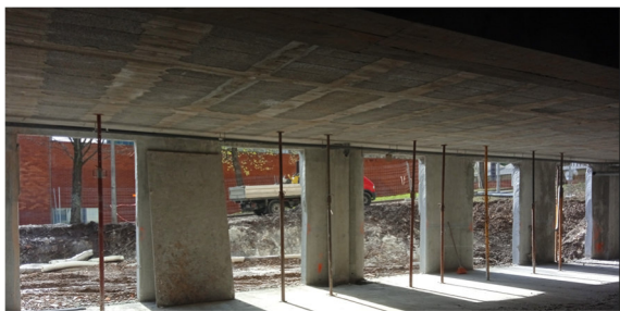
Figura 31: Escoramento provisório
