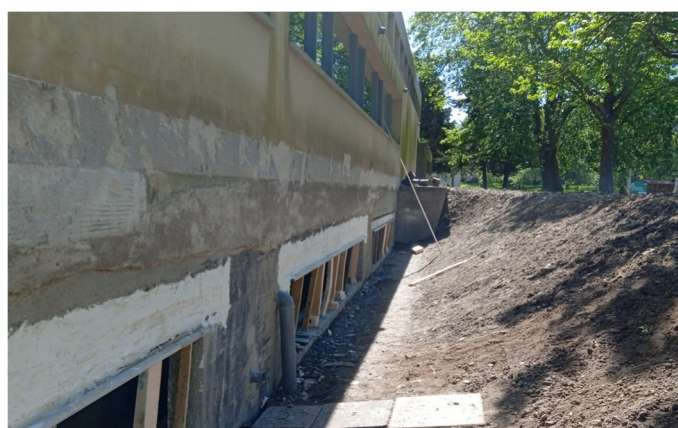
Figura 87: Fixação e isolamento Perfis HEA (2)
