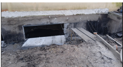
Figura 30: Abertura de vãos
