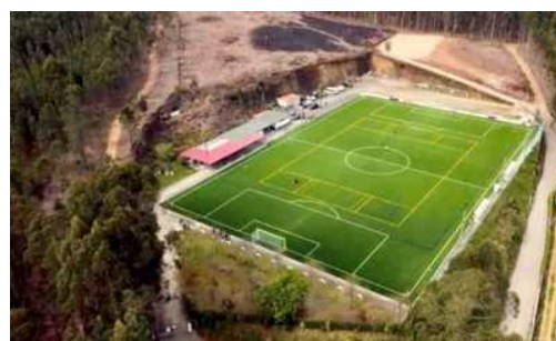
Figura 3 – Complexo Desportivo de S. Martinho
