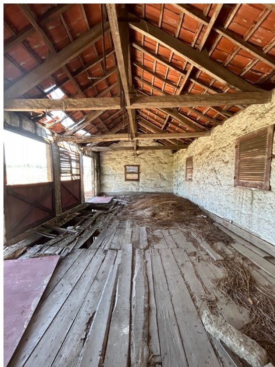
Figura 33 - Piso superior do beiral. Fonte: Carolina Ferreira
